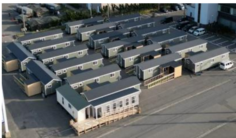
令和6年能登半島地震 トレーラーハウスによる応急仮設住
